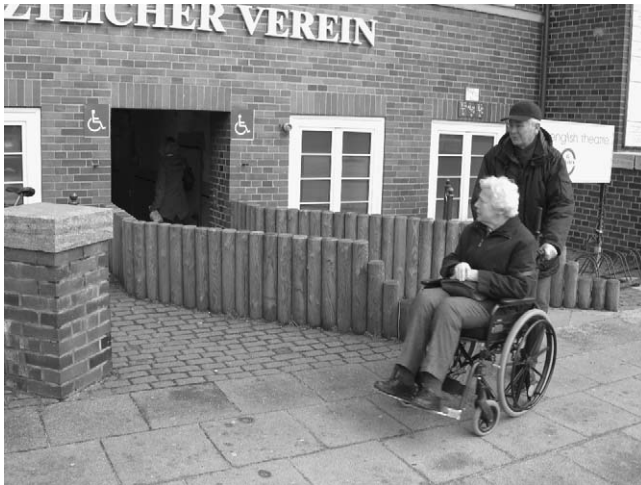
Abb. 6 Behindertenzugang durch ein Untergeschoss.
